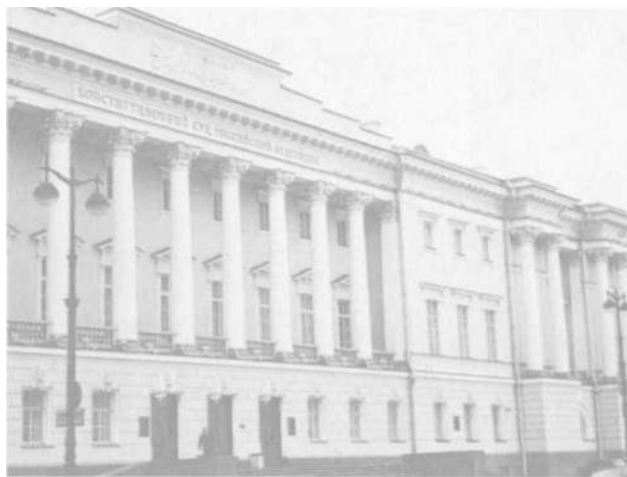
Рис. 1. Здание Конституционного Суда РФ в Санкт-Петербурге
